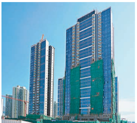
■啟德1號(I&II)大廈外觀。
