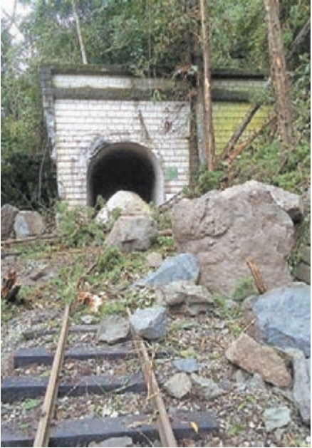
■阿里山森林鐵路去年受豪雨影響，邊坡土石滑落，不僅損毀隧道，而且列車也無法通行。 資料圖片
