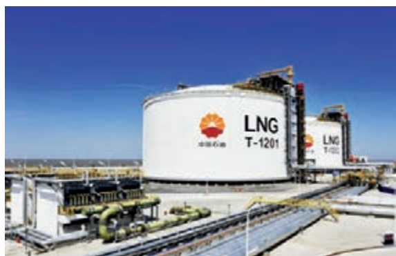
■中國石油LNG接收站
