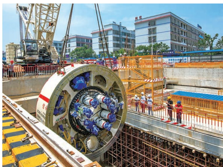
長沙地鐵第三期規劃正在抓緊施工
