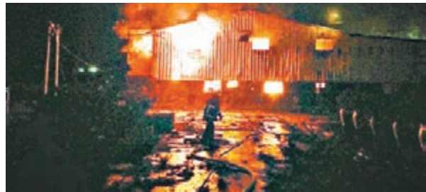
在貨運行火災現場，消防員正在施救。
