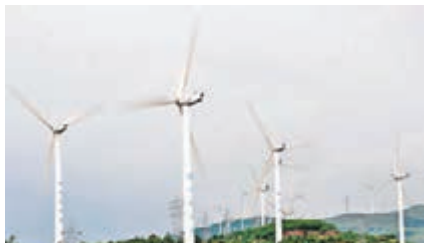
根據規劃，到2020年，內地全部可再生能源發電裝機6.8億千瓦，佔全部發電量的27%。圖為雲南大理市大風場風電場。
