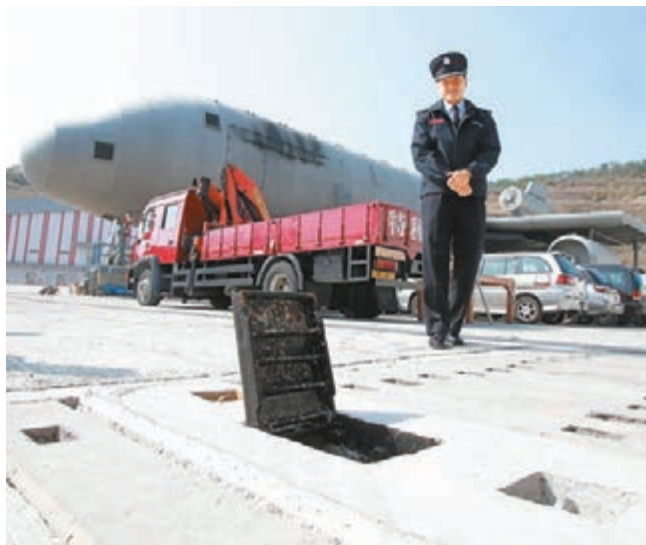
消防處指在模擬飛機事故訓練中有人因未熟習操作，沒有即時打開控制閘門，導致泡沫經雨水渠誤排至山澗。彭子文攝
