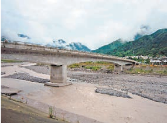
■綿茂公路（漢旺至清平段）——清平場鎮大橋。
