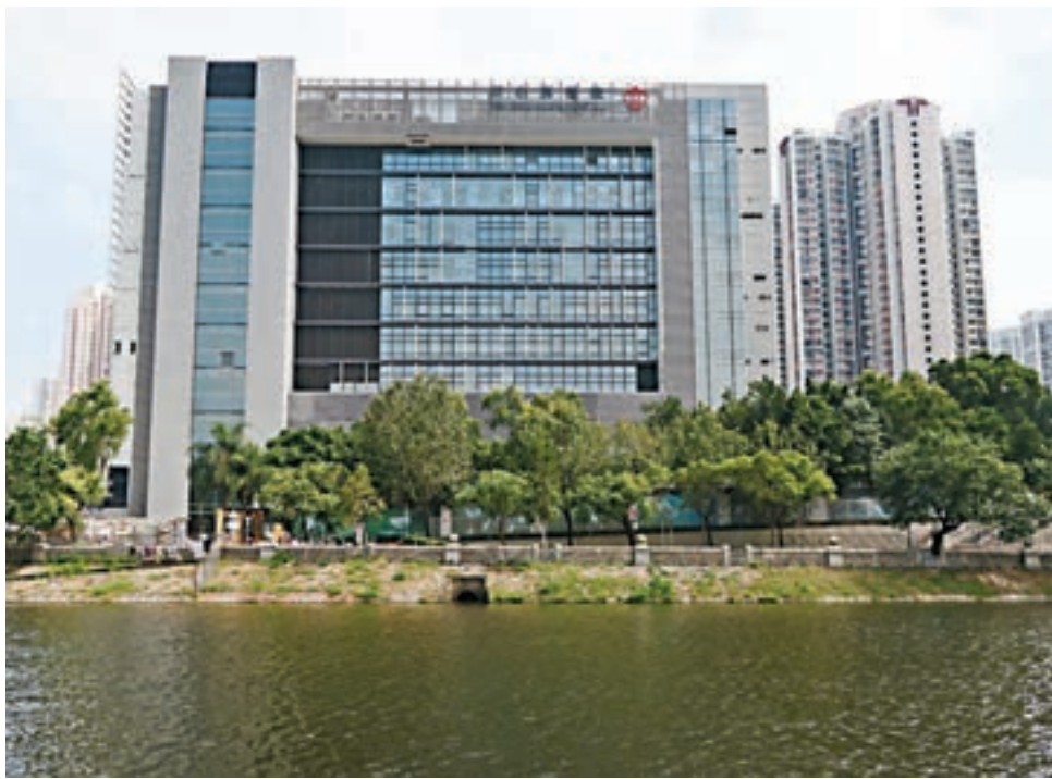
天水圍醫院明年初分階段投入服務，大樓採用玻璃幕牆設計，加強採光。
