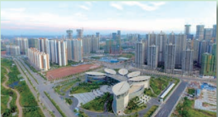
■建設中的五象新區
