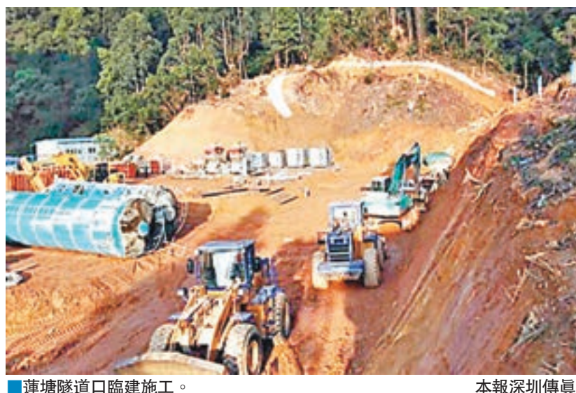
連塘隧道口臨建施工。 本報深圳傳真
