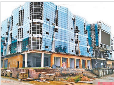
未完工的「樓梯」樓。
