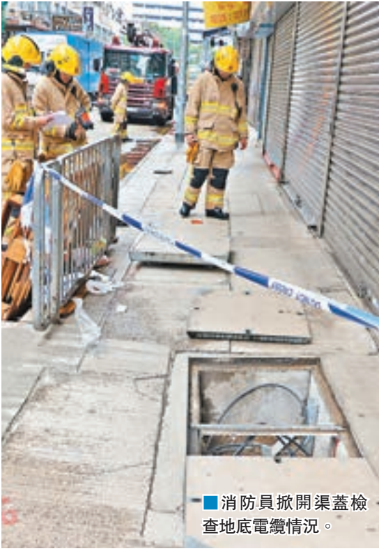
中電人員（藍衣）與消防員掀開渠蓋檢查地底電纜。 劉友光 攝
