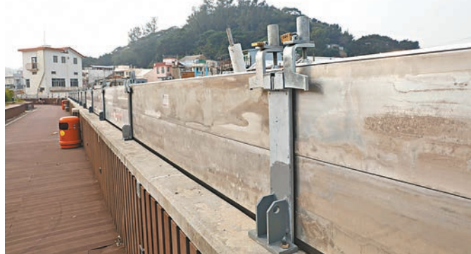
■大澳有全港首個加裝可拆卸式防洪屏障的河堤，最高可抵擋3.8米高的湧浪。 劉國權 攝
