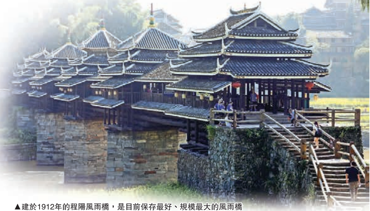
▲建於1912年的程陽風雨橋，是目前保存最好、規模最大的風雨橋
