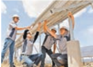
工作人員巡查光伏發電電板和線路。資料圖片
