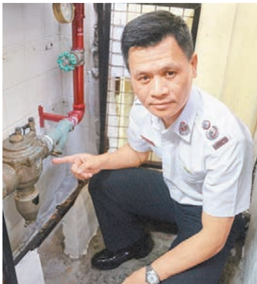
趙偉乾解釋防止回流裝置,確保污水不會倒流,保障公用水源不受污染。梁祖彝攝
