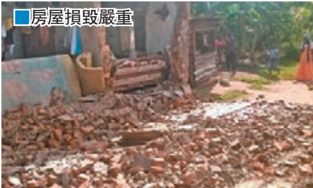
■房屋損毀嚴重
