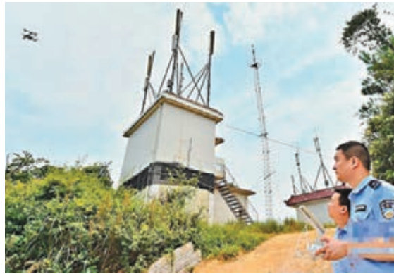
■在福建安溪縣長坑鄉，民警使用無人機對位於深山的電信基站周邊進行巡查。 網上圖片
