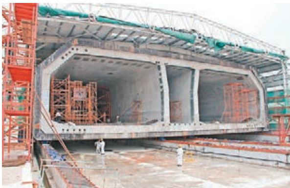
■作為港珠澳大橋施工中最難的部分，海底隧道由33節巨型沉管對接而成，圖為沉管預製現場。 方俊明 攝
