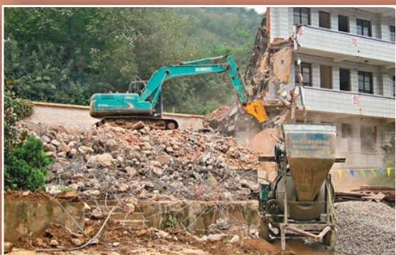
■震後鄒家村小學教學樓被整體拆除，學生們只能在夏熱冬涼的板房裡上課。
