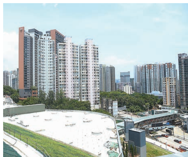
何文田站8層樓宇結構依山而建，高低落差超過70米，通車後將是港鐵面積最大及層數最多的中轉站。 梁祖彝攝
