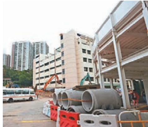
聯合醫院現進行新日間醫護大樓及S座新翼的下層結構工程。
