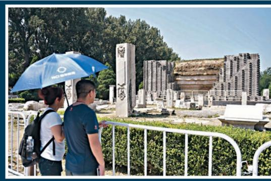
歷時兩個月的圓明園西洋樓遺址海晏堂蓄水樓本體加固工程昨日正式竣工。海晏堂曾是僅次於遠瀛觀的圓明園標誌性建築物，後遭八國聯軍焚燬。加固保護工程嚴格按照「不改變文物原狀」和「原形制、原結構、原材料、原工藝」的原則進行施工，主要對夯土四角進行包磚支護、頂部防水處理等。
