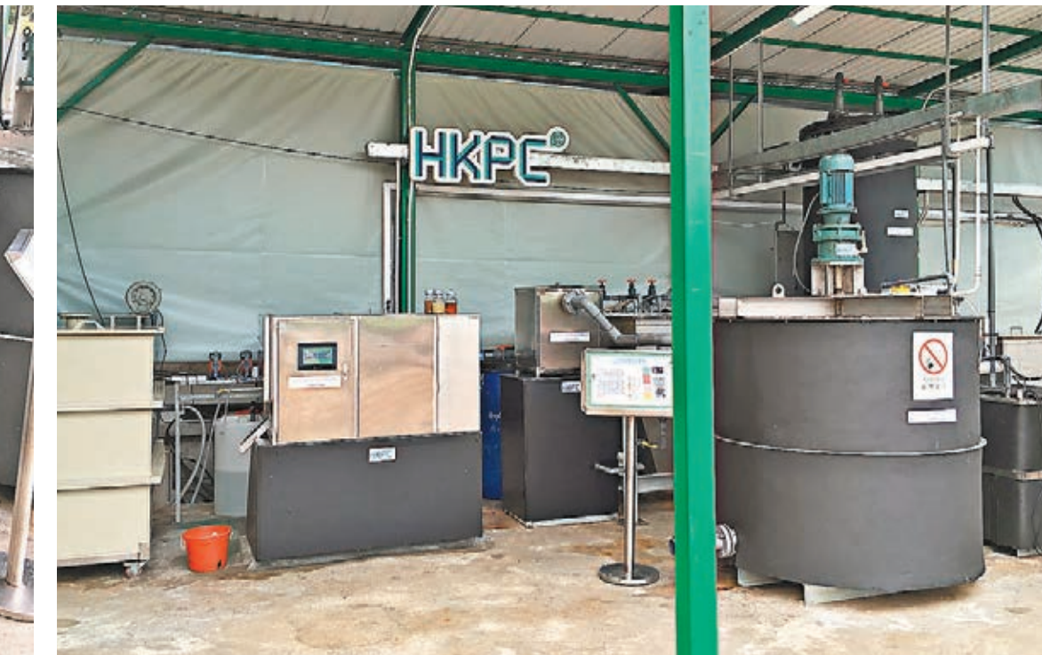
■首階段自動廚餘篩選機(左)及次階段可分解有機物的反應器。 馮健文攝
