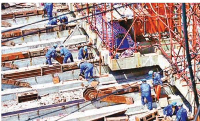
■工人在施工現場緊張作業。
