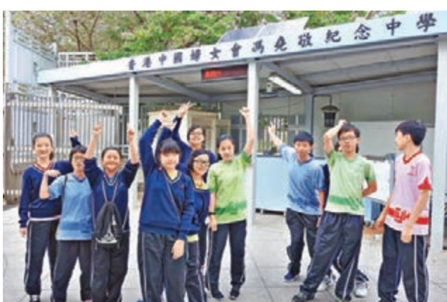
■ 校門的保安亭頂部安裝了太陽能光伏板。 校方供圖
