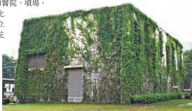
■ 大坑東水泵房的綠化工程。 資料圖片
