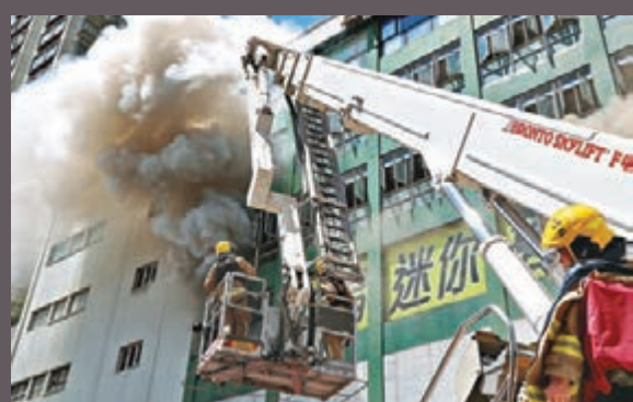
■四級奪命火現場，消防盡力灌救。 曾慶威 攝
