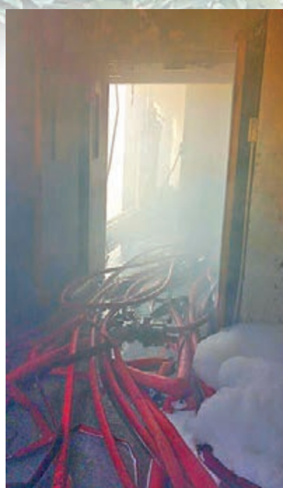
■可見燒毀的電線及救火喉鋪滿地，消防員很容易被絆到。
