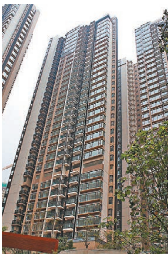
林姓買家捷訂東涌昇薈2個單位,料損手超過182萬元。
