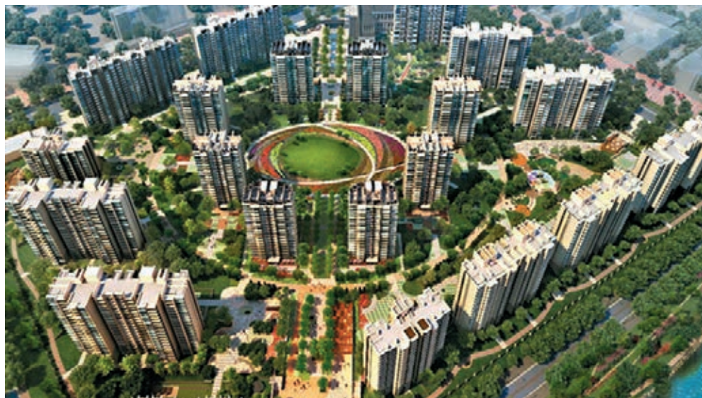
■上海嘉定地昨拍賣,一幅創下單價地王紀錄,另一幅則創下溢價率新高。圖為該區金通路1737弄(近桂溪路)。
