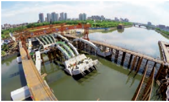
■建設中的跨北運河大橋
