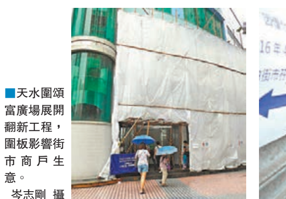
天水圍頌富商場展開翻新工程,圍板影響街市商戶生意。
