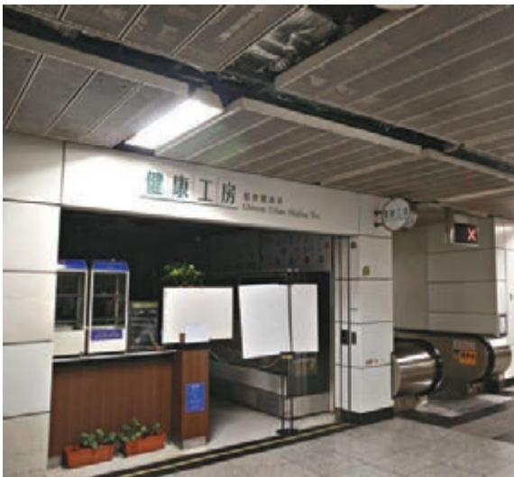
中環港鐵站停電，部分商店受影響須暫停營業。
