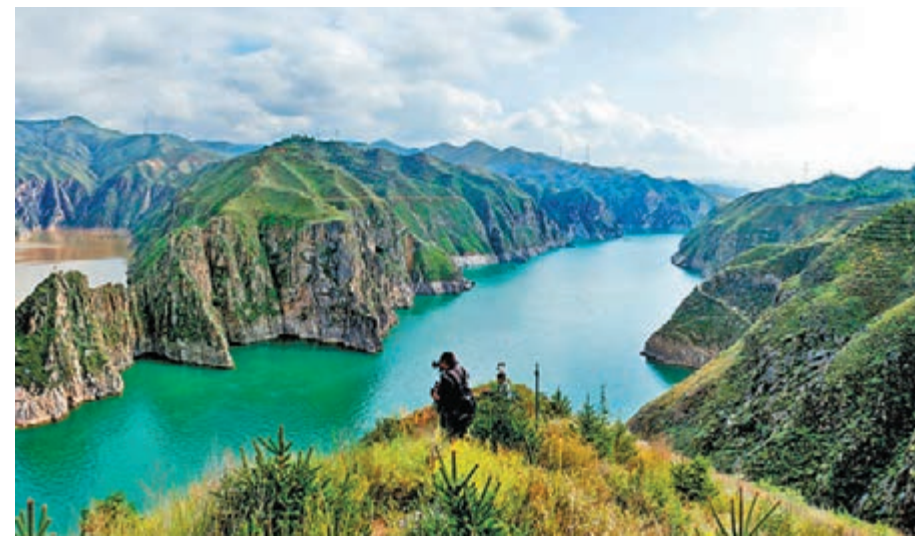
■蘭州市第二水源地項目取水地劉家峽水庫碧波蕩漾。
