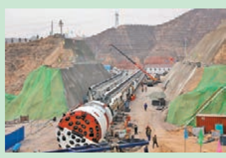
■雙護盾岩石隧洞TBM盾構機組裝完成，準備進洞施工。
