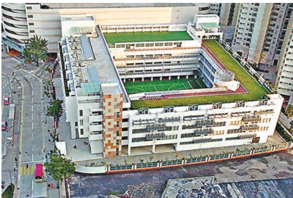
本港多間中小學天台均建有綠化設施。
