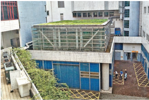
城大學術樓(一)實驗室天台草被將拆除。 楊佩韻攝
