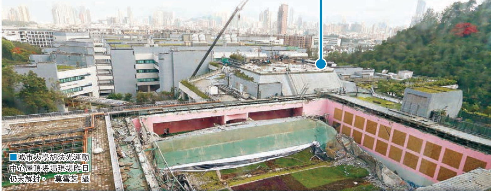
毗鄰坍塌現場的惠卿劇院屋頂緊急拆除植被。 莫雪芝攝
