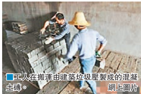
工人在搬運由建築垃圾壓製成的混凝土磚。
