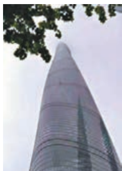
■ 發生玻璃墜落的上海中心大廈。網上圖片
