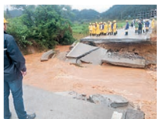
通往現場的路上,一座橋樑被洪水沖垮。中新社
