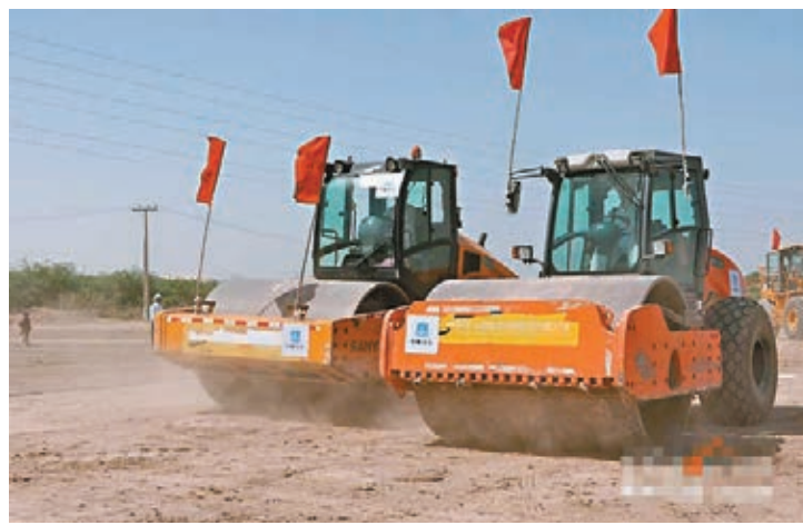
白沙瓦至卡拉奇高速公路項目（蘇庫爾至木爾坦段）工地現場。網上圖片
