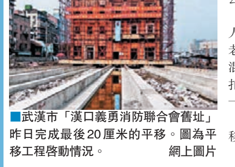
武漢市「漢口義勇消防聯合會舊址」昨日完成最後20厘米的平移。圖為平移工程啟動情況。網上圖片
