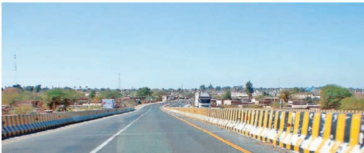
亞投行首個項目將是巴基斯坦一條連接旁遮普省的紹爾果德與哈內瓦爾的高速公路。圖為哈內瓦爾一隅。網上圖片
