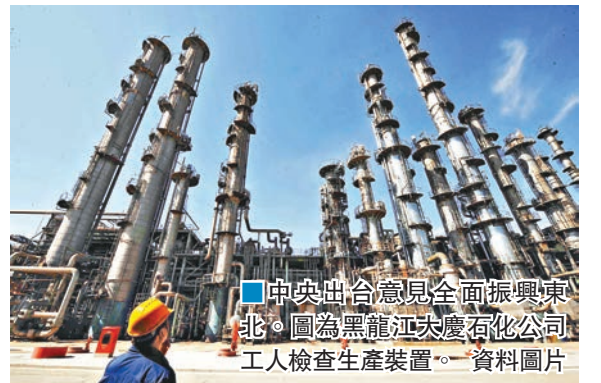
■中央出台意見全面振興東北。圖為黑龍江大慶石化公司工人檢查生產裝置。資料圖片
