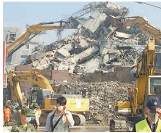
■維冠案昨日開庭。今年2月6日台灣發生強震，其中維冠大樓倒塌造成115人死亡，後被揭發大樓建商偷工減料。圖為早前搜救圖片。
