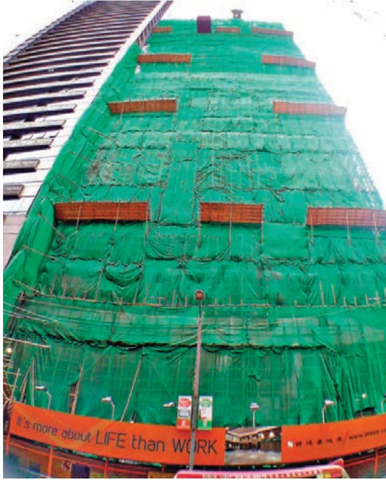
長沙灣青山道668號現址仍在興建中，該廈18層標準樓層樓花已沽清。張偉民攝
