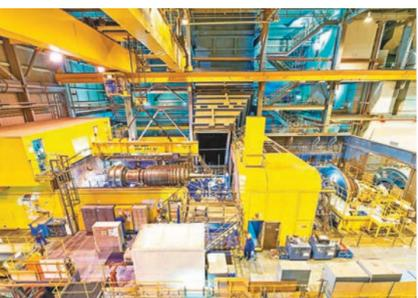
現時位於龍鼓灘發電廠的燃氣機組，已採用聯合循環燃氣渦輪設計。 中電供圖
