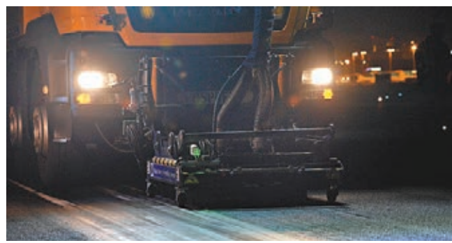
高壓洗膠車釋放高壓水力，把跑道膠屑打為粉末吸走，避免飛機「跌胎」。
