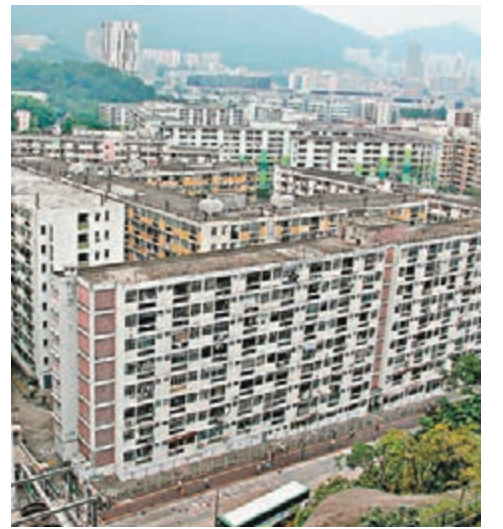
石硤尾大坑西邨重建擬將民樂樓及民康樓先行拆卸。資料圖片
