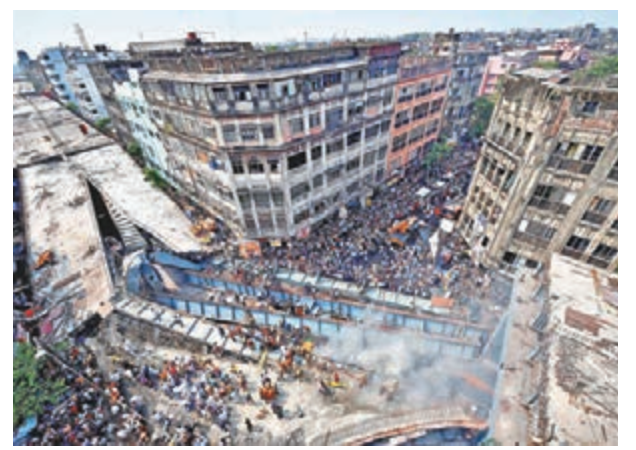
大橋塌下壓毀多部車輛，現場位置有如廢墟。
